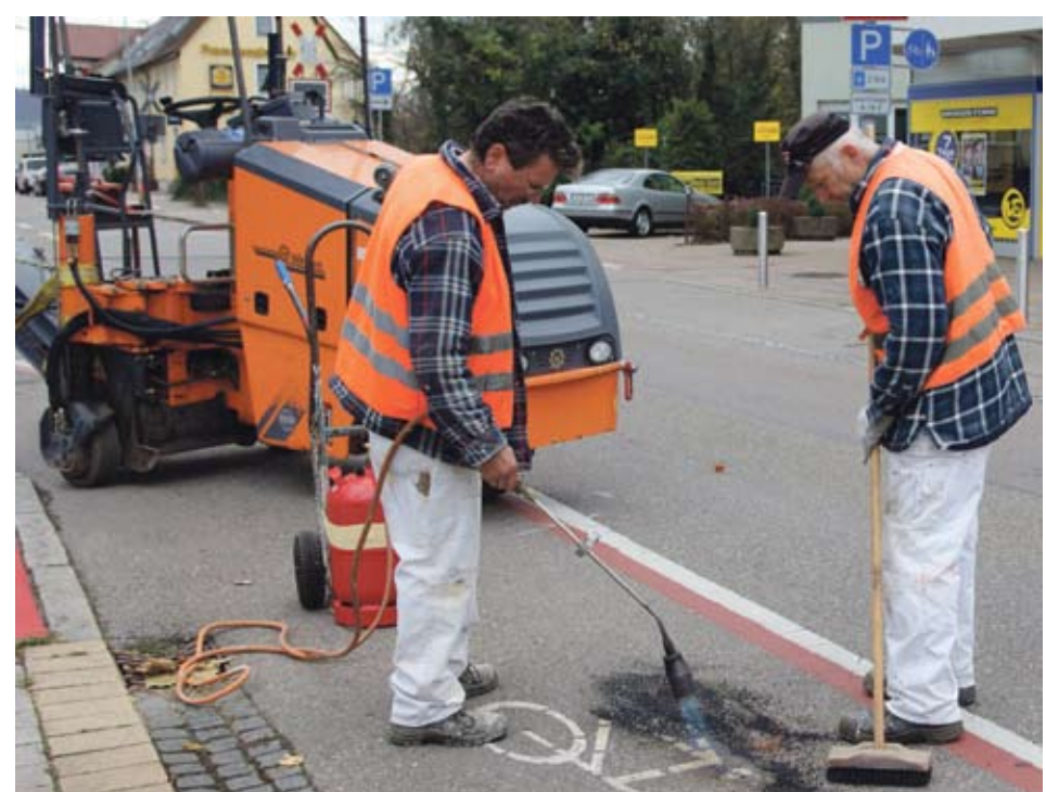
Walter Holzäpfel und Ottmar Hettich entfernen die Fahrrad-Markierungen auf der Fahrbahn.
