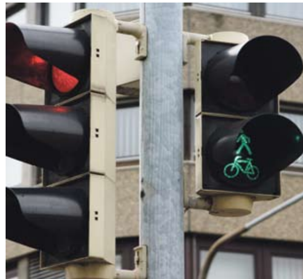
Wenn Fußgänger queren wollen und die Ampel drücken ist die „Grüne Welle“ für den Autoverkehr unterbrochen.
